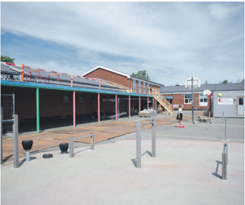
Håndværkerne fylder godt op på Paradisbakkeskolen. Flere store ombygninger er i gang på samme tid.
