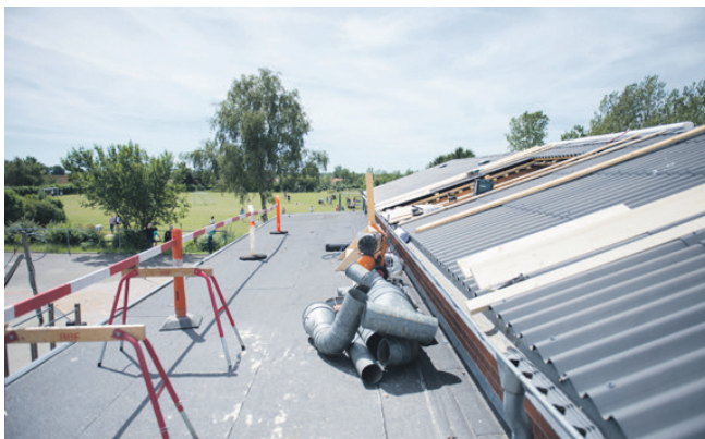
Paradisbakkeskolen får ny ventilation i samtlige undervisningslokaler. Håndværkerne går ned gennem taget til hver enkelt klasselokale.
