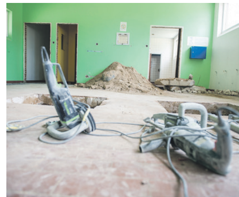
Det nye produktionskøkken etableres i de gamle omklædningsrum til skolens tidligere gymnastiksal.
