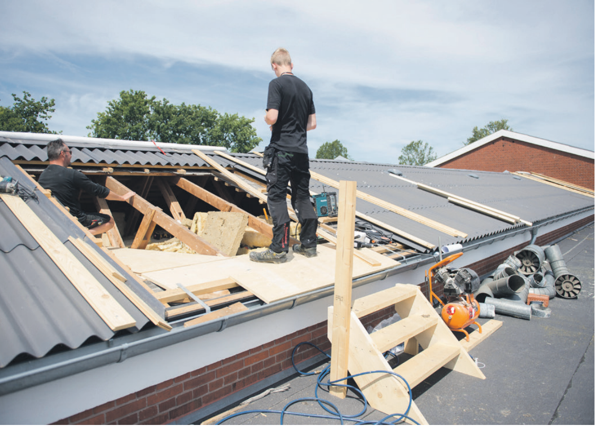
I denne uge arbejdes blandt andet på ventilation og det nye produktionskøkken til madskolen.
